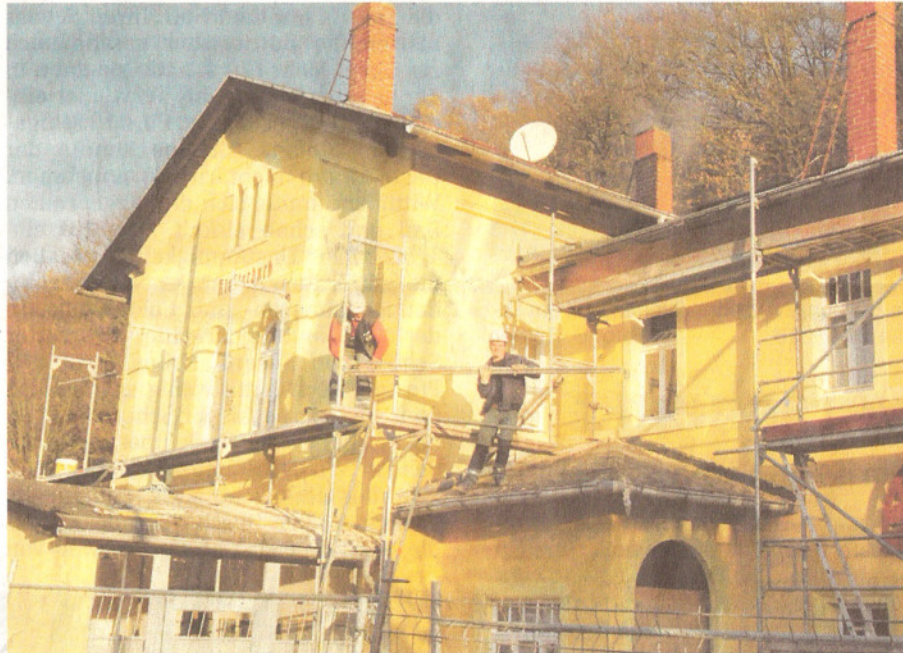
Das Gerüst verschwindet – damit ist der Bahnhof Kloster Buch der einzige restaurierte Bahnhof auf der Strecke zwischen Leipzig und Nossen. DAZ-Foto: J. Kulschewski
